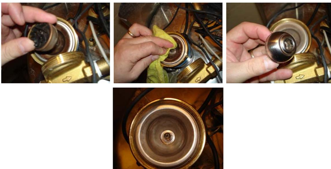
Bitte entfernen Sie das Pumpenrad und reinigen Sie dieses zusammen mit dem Pumpengehäuse feinsäuberlich
